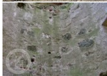
Současné fotografie - exteriér - detaily stavebních prvků
