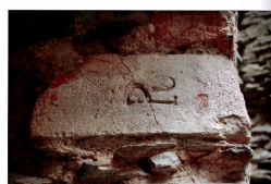
11. Radvanov – detail chýby se měřicí chýby v doměnované základě v přístroji větrného mlýna. Símě stánek, květen 2010.
