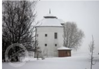
Současné fotografie - exteriér - detaily stavebních prvků
