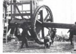
Obč. 12. Převodní kolo s patřičným náhonem. Foto K. Hájek
