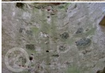
Současné fotografie - exteriér - detaily stavebních prvků
