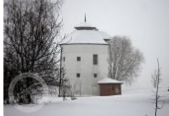
Současné fotografie - exteriér - detaily stavebních prvků
