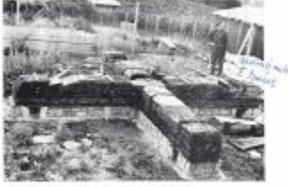
Obč. 8. Základy mlýna v kamenné v kamenné Foto Z. Balaš
