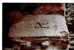
11. Radvanov – detail chleby se mělním chleby v domě zámku v přístřeží větrného mlýna. Snímek autor, červen 2010.
