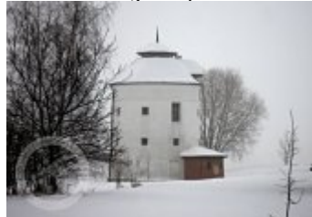
Současné fotografie - exteriér - detaily stavebních prvků
