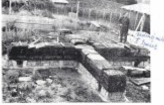
Obč. 8. Základy mlýna v kamenné zdivu. Foto J. Hájek
