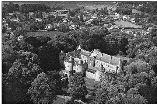
Zámek Corroy v Belgii – současné sídlo rodu de Trazegnies
