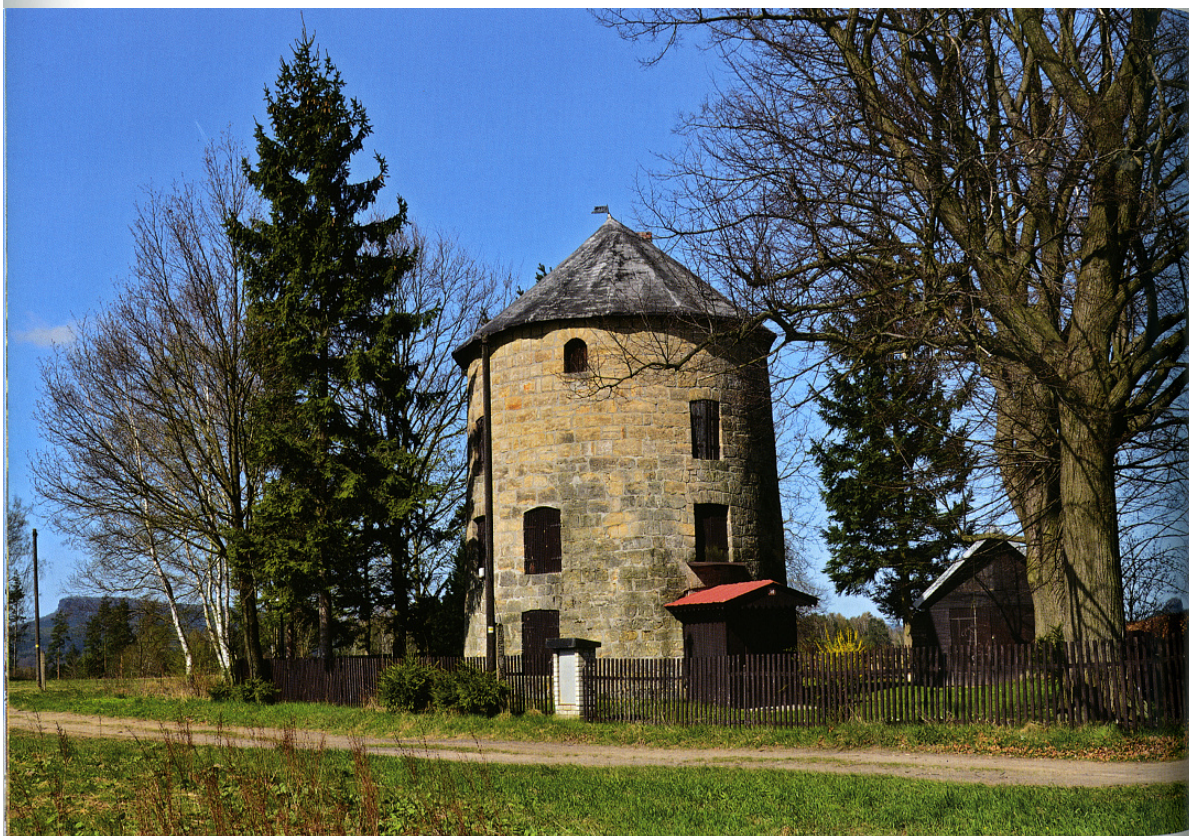
Zděný větrný mlýn holandského typu byl postaven v r. 1844 sedlákem Antonem Richterem
