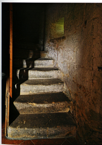
Dochovaná část schodiště
